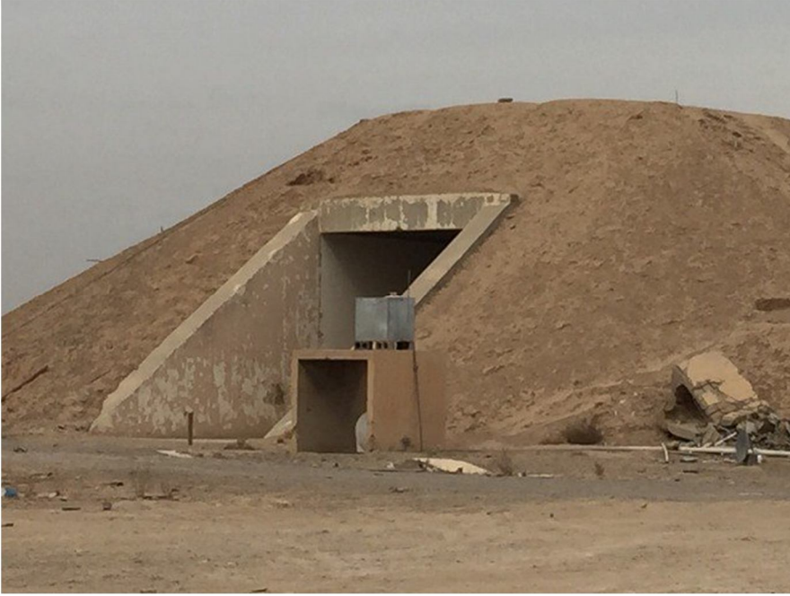
صورة لاحد مداخل المخازن في منشأة المثنى
