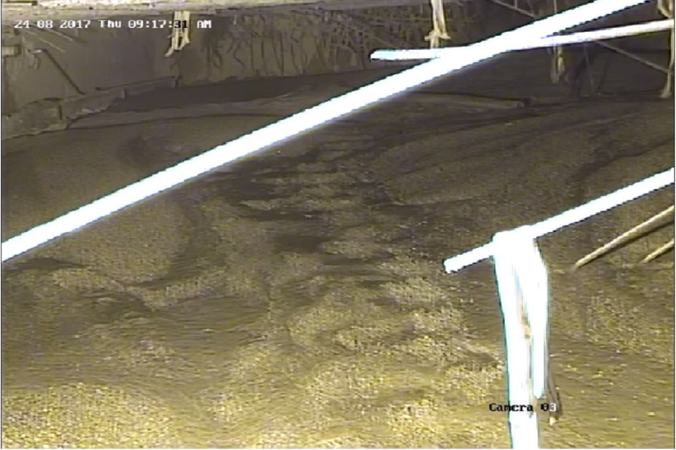
مراحل حقن الاسمنت الرغوي في مخزن(13)
