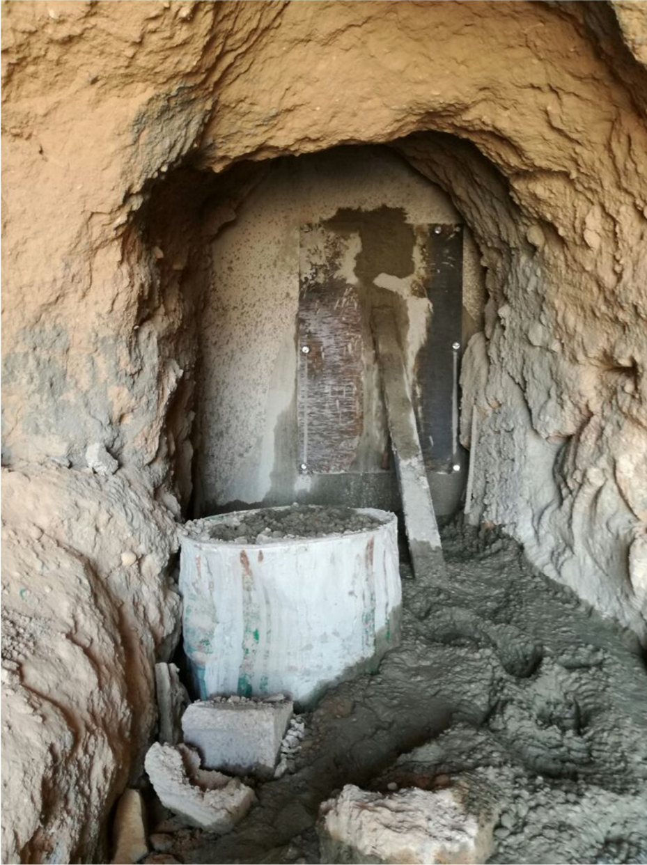
اغلاق إحدى الفتحات في جدار مخزن (41) بعد الإنتهاء من تدميره
