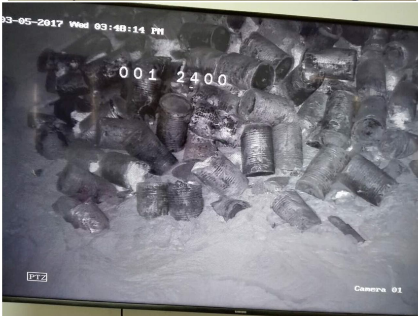
مخزن (13) اثناء عملية الحقن بالاسمنت الرغوي
